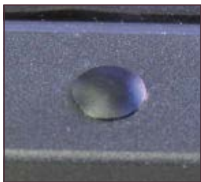
Vite autoforante con testa svasata e tappo nero di finitura
